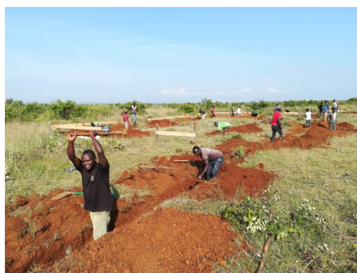
scavi per la realizzazione delle fondazioni
