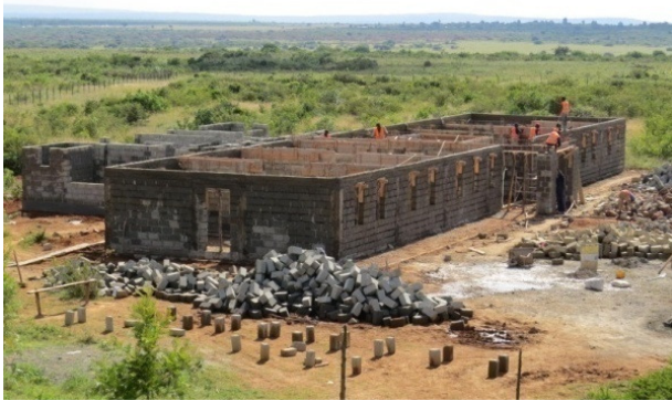
realizzazione delle strutture murarie in elevazione
