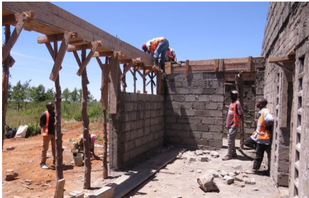
realizzazione dei cordoli sommitali
