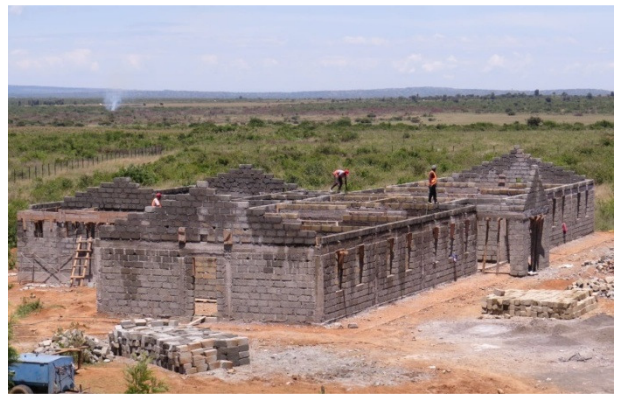
realizzazione dei timpani di copertura
