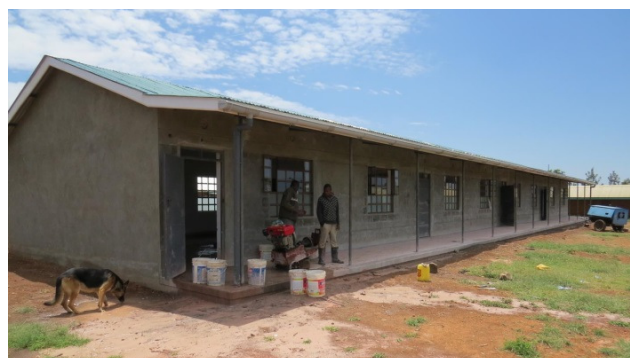
costruzione aule in muratura permanenti
