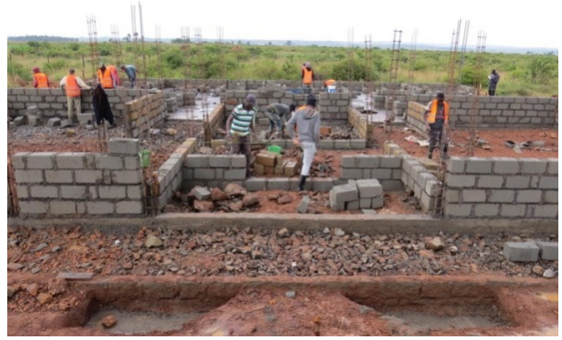
cordoli di fondazione e inizio delle strutture murarie
