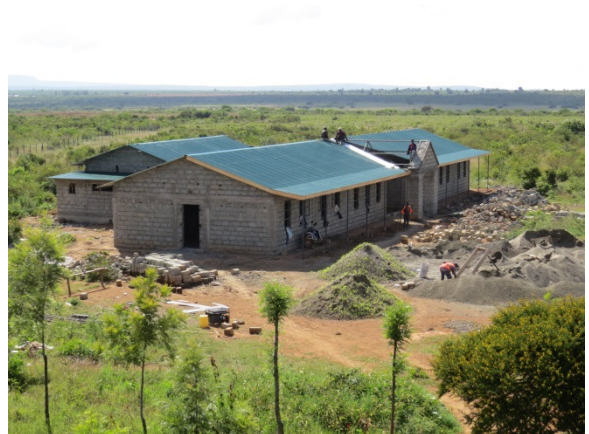
realizzazione della copertura
