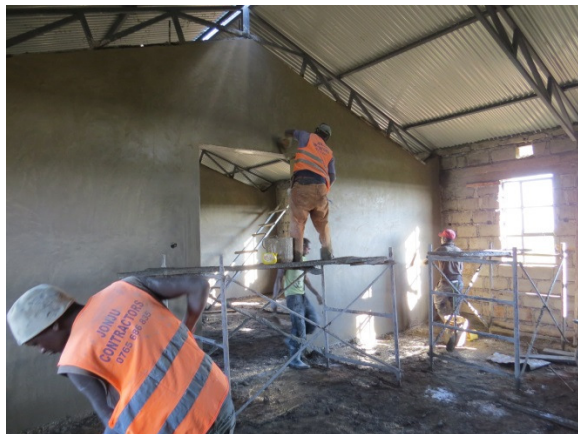
realizzazione degli intonaci interni
