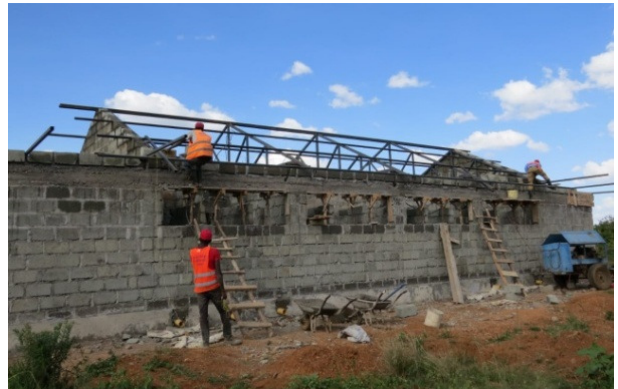
posa delle capriate e dell'orditura di copertura
