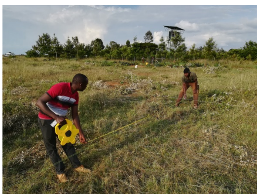
misurazione preliminare del sito e tracciamento riferimenti
