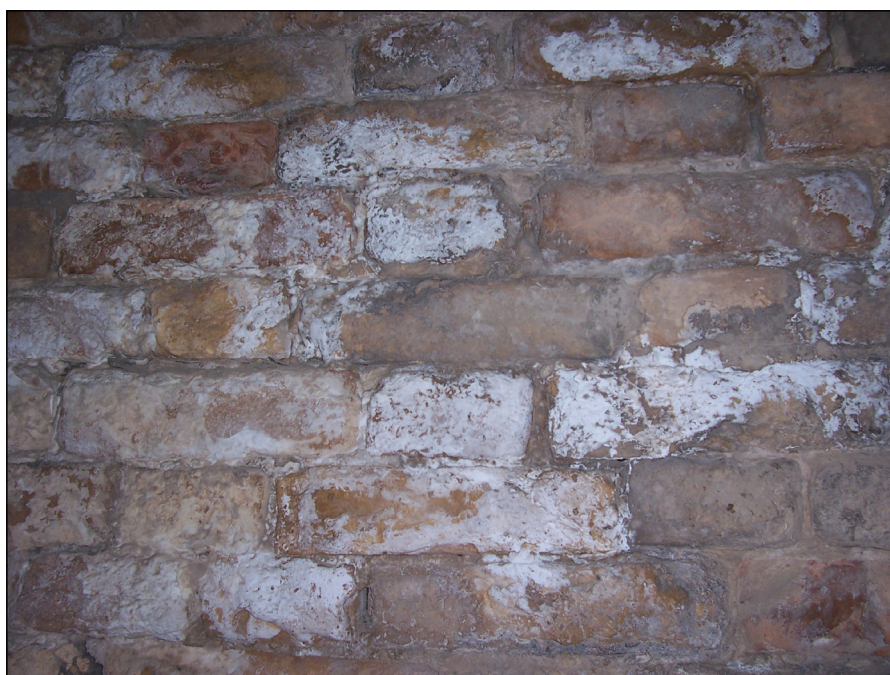
Foto 11 - Nord, muratura con efflorescenza salina.
