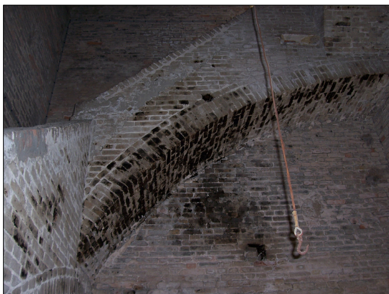
Foto 6 - Sud, arco rampante con zona di muratura bruciata.
