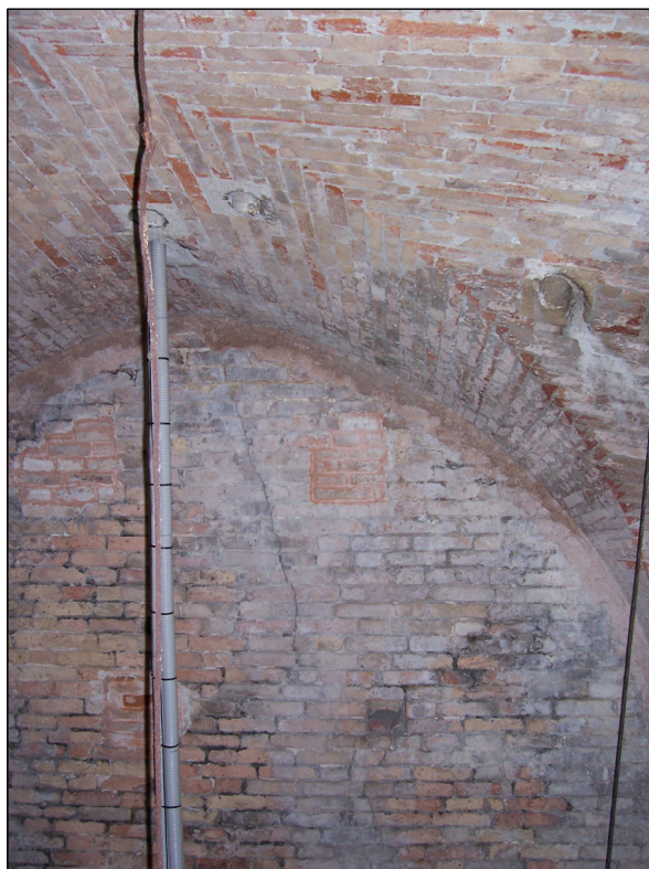
Foto 8 - Ovest, lesione sotto volta a crociera della cella.
