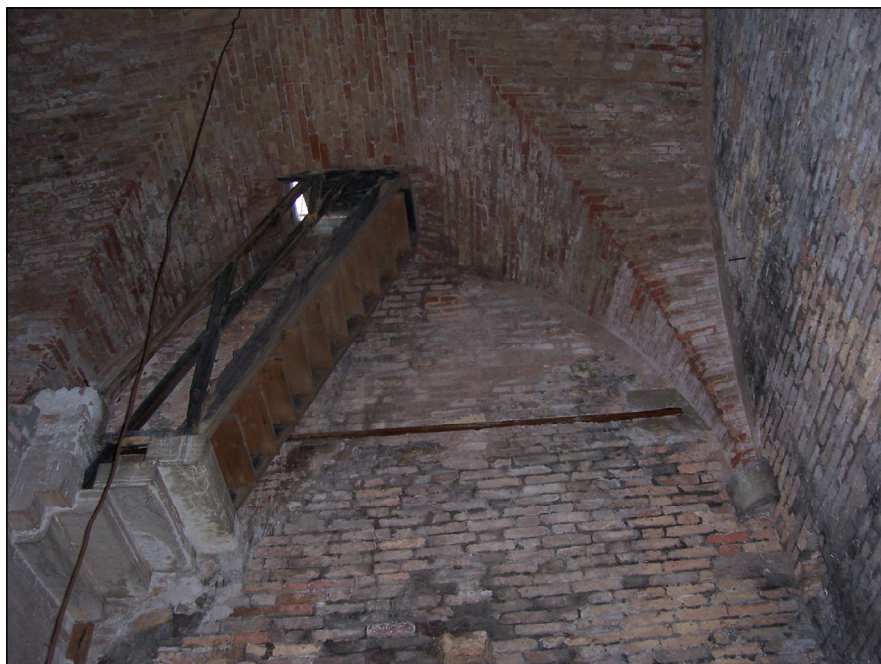
Foto 7 - Volta a crociera del solaio della cella, tirante e zona risarcita su Est.
