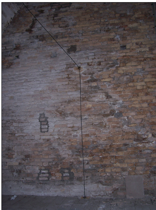
Foto 10 - Nord, sostituzioni murarie tra 1° e 2° solaio.
