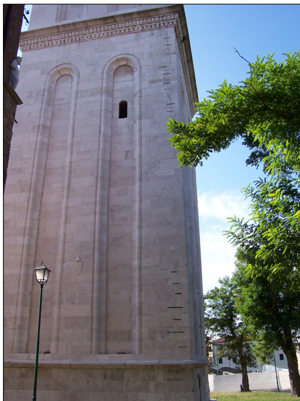
Foto 3 - Prospetto Est, angolo E - N, paramento esterno risarcito con grappe.
