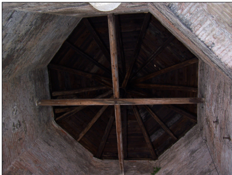
Foto 4 - Copertura e tamburo con tiranti lignei.
