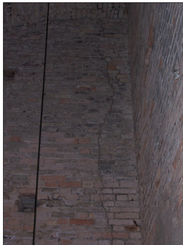
Foto 9 - Ovest, lesione da + 18 m a +8,2 ampia 10 - 15 mm.N.R. se passante.
