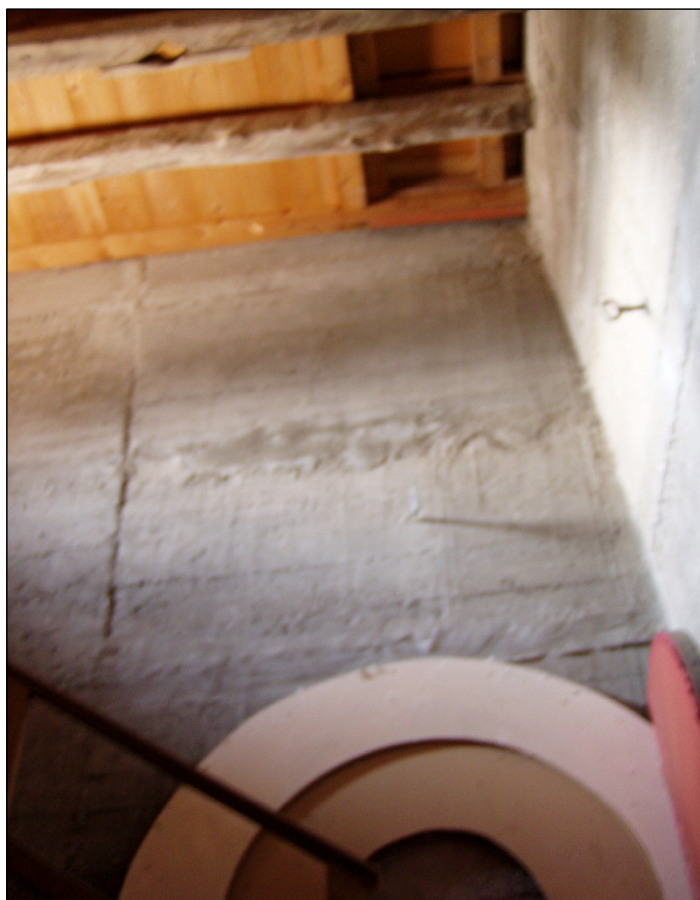
Foto 5 - Foderatura in c.a. dell'interno della canna da quota +2.80 a +10.40
