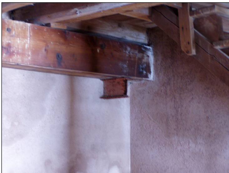
Foto 10 - Putrelle di rinforzo al di sotto dei solai lignei.
