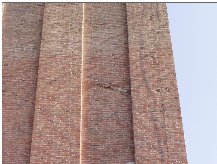
Foto 9 - Lesione obliqua con traslazione dei lembi (lato Ovest).
